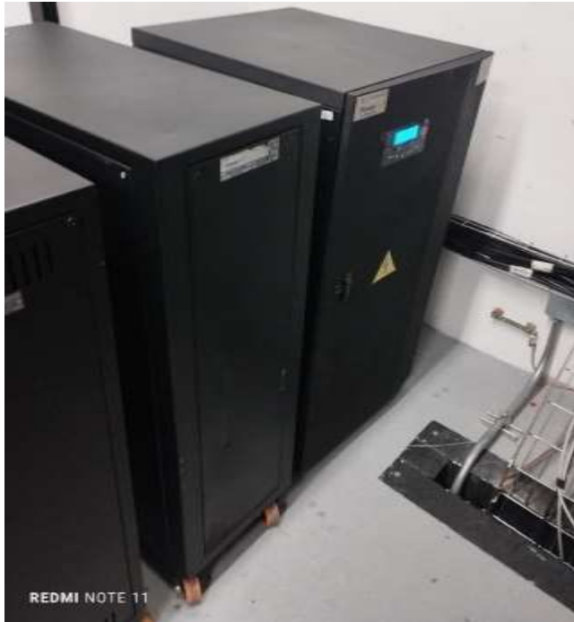
Sistema de alimentación ininterrumpida (UPS) y sus bancos de baterías
