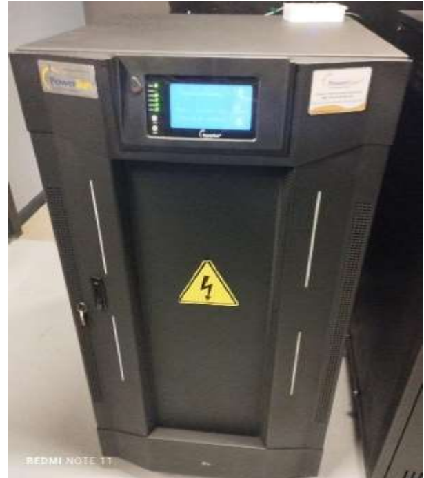
Sistema de alimentación ininterrumpida (UPS) y sus bancos de baterías
